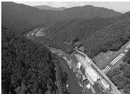
日野谷発電所
