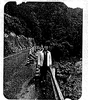
2018年8月15日 7月豪雨災害で被災した山城町白川谷視察 今も関係者の皆様が復旧作業に取り組んでくれています。
