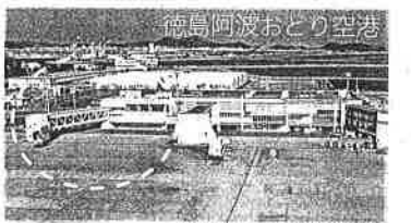
徳島阿波おどり空港 入出国検査場、税関検査場等整備
