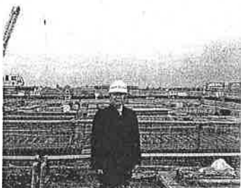
金磯岸壁改修工事を視察 (小松島市金磯町 2017.12.18)
