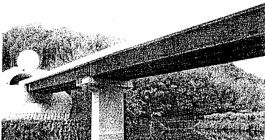
国横断自動車道 田野地区 西溜池橋
