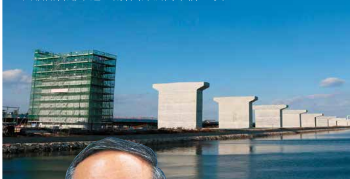
四国横断自動車道の南伸(沖洲高架橋工事)
