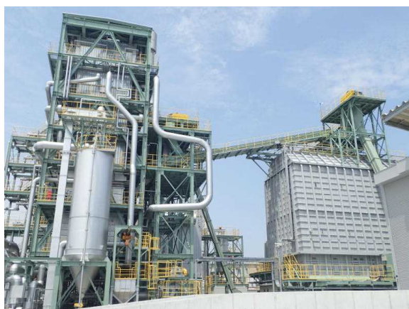
クラボウ徳島バイオマス発電所
