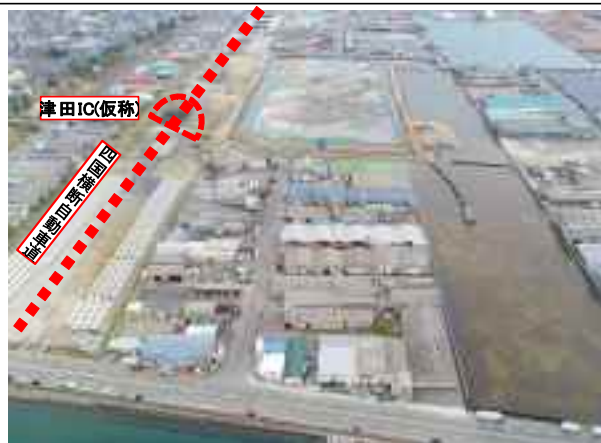
徳島小松島港津田地区 令和元年度 埋立地の分譲開始
