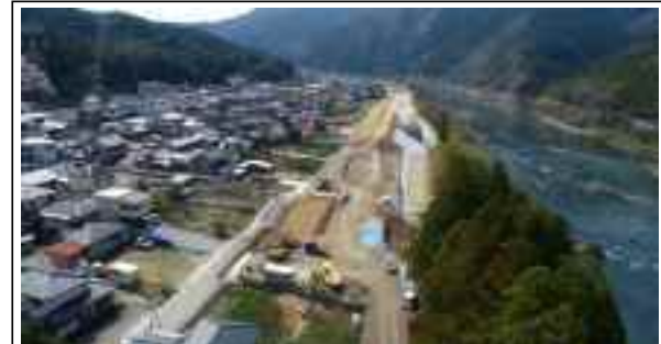
那賀川床上浸水対策特別緊急事業(和食・土佐地区) 河川堤防 令和2年度完成予定
