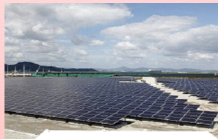
和田島太陽光発電所
