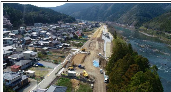
那賀川床上浸水対策特別緊急事業(和食・土佐地区) 河川堤防 令和2年度完成予定
