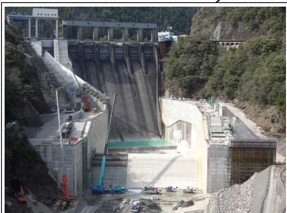
長安口ダム改造事業 新設洪水吐ゲート 令和元年度完成予定
