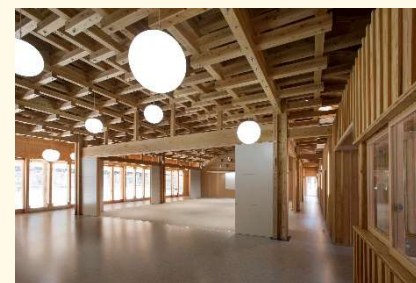
徳島県木材利用創造センター 林業人材育成棟
