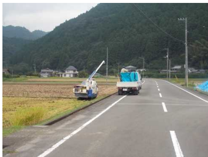
優良農地を支える基盤整備(農道)
