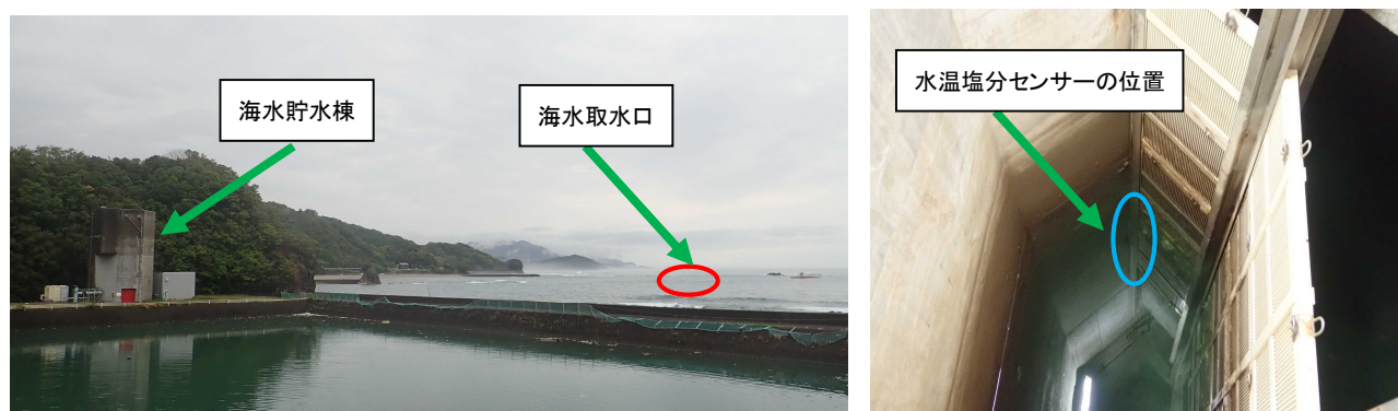
写真 1. 海水貯水棟と海水取水口(左写真)及び海水貯水棟内の着水槽(右写真)
