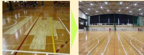
体育館 床の傷み
