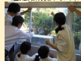
ガラス飛散防止フィルム貼り
