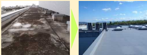
校舎 屋上防水の劣化
