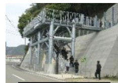
避難施設の整備
