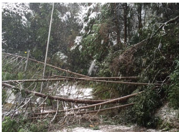
平成26年12月豪雪による被害 (三加茂東祖谷山線)
