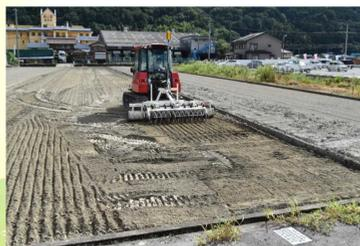
レーザーを受光し、正確に傾斜をつける
