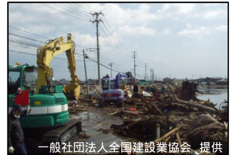
【陸域の啓開・応急復旧作業状況】
