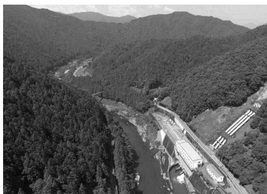
日野谷発電所
