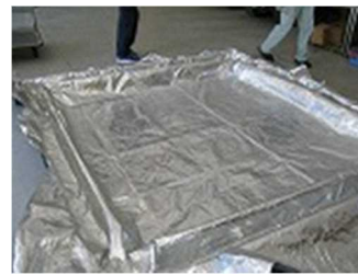
③水封枠にベースシート挿入
