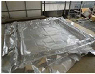
②ベースシートの設置
