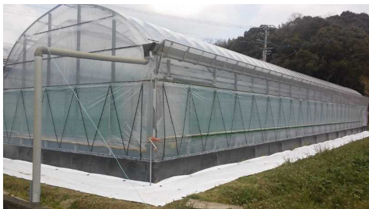
図VI-1 施設外周における乱反射シートの敷設
