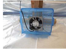
⑥ガス攪拌ファンの設置
