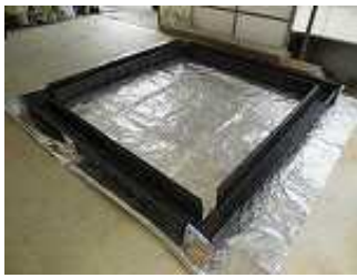
①水封枠設置
