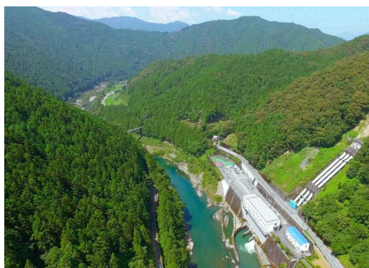
日野谷発電所
