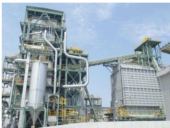
クラボウ徳島バイオマス発電所
