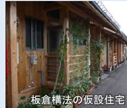
板倉構法の仮設住宅
