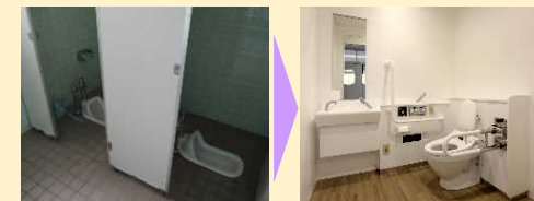
多目的トイレ
