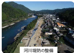
河川堤防の整備
