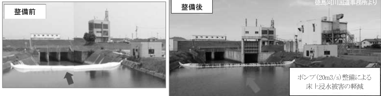
写真2-27 角ノ瀬排水機場の整備前後(徳島市)
