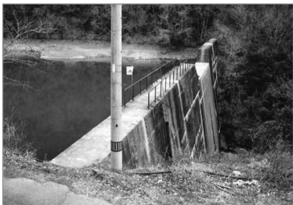
施策2-1 砂防堰堤に貯まった流水の利用
