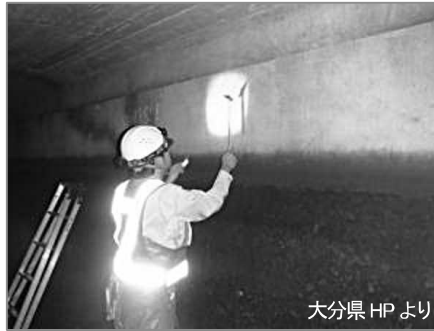
施策4-1 工業用水の隧道の点検
