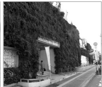
施策3-3 壁面緑化などによるグリーンインフラの整備(とくぎんトモニプラザ)
