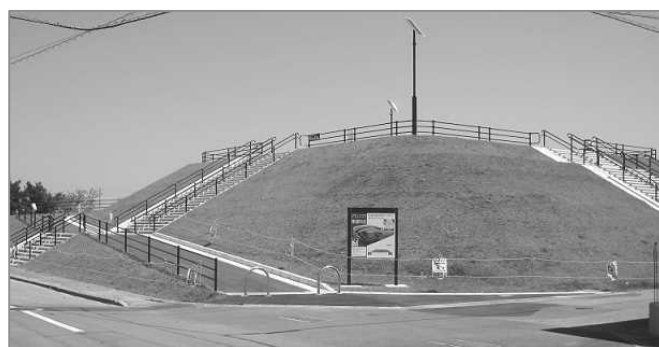
施策3-2 除去した土砂を有効活用した津波避難施設(小松島市)
