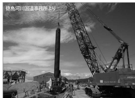
写真2-35 液状化対策工事
