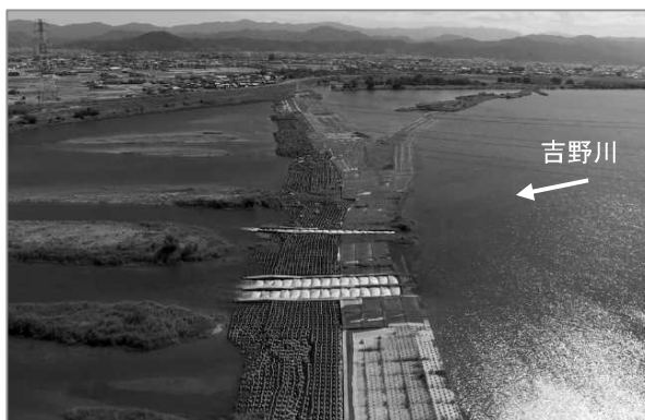
写真2-21 第十堰(石井町・上板町)
