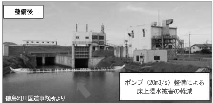
施策1-6 排水機場の整備(角ノ瀬排水機場)
