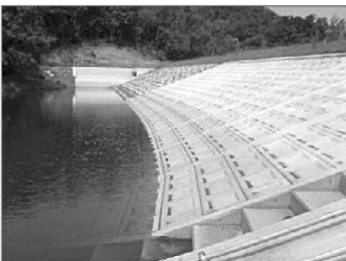
施策4-4 農業用水の安定化を図るため整備されたため池
