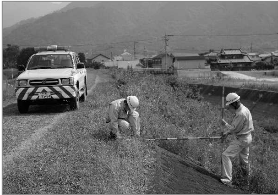
施策4-1 堤防の点検状況
