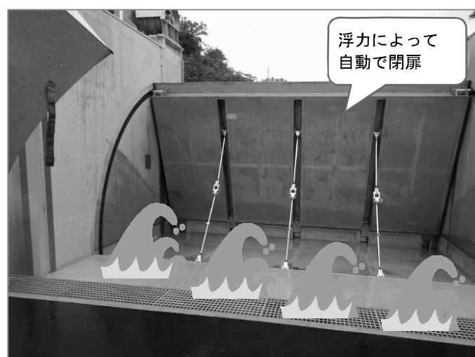
施策2-2 陸閘閉鎖の自動化
