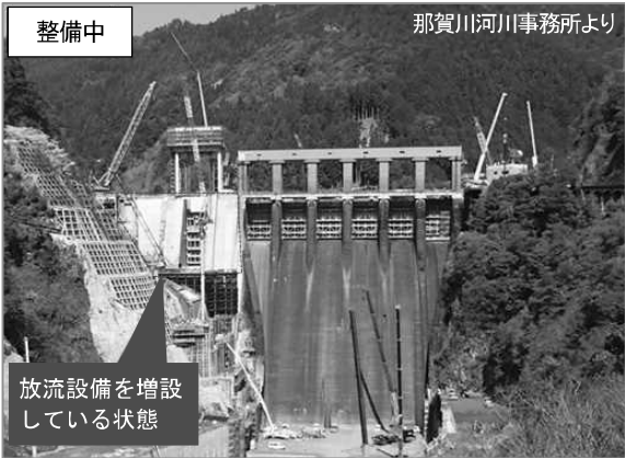
施策1-3 ダム洪水調節機能の強化(長安口ダム改造事業)
