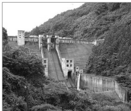
写真2-23 正木ダム(上勝町)
