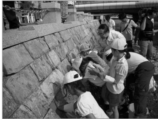
施策4-2 県民との協働による護岸の修理(新町川)
