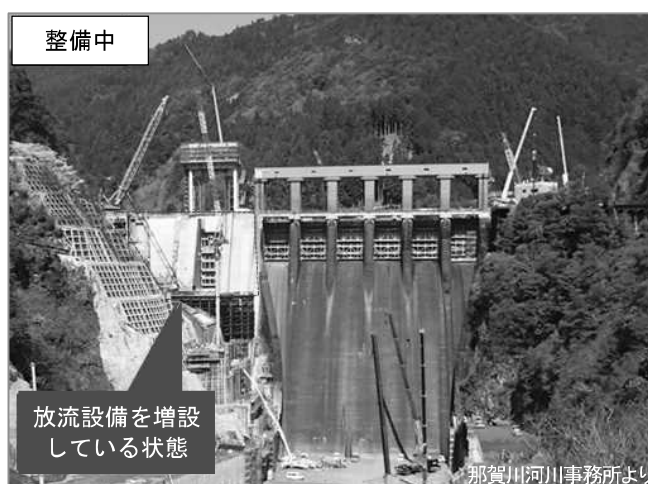
写真2-32 長安ロダムの改造(那賀町)
