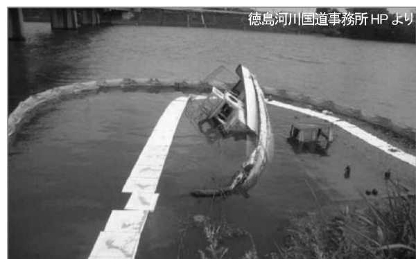
施策2-4 シルトフェンスによる油等拡散防止 徳島河川国道事務所 HP より
