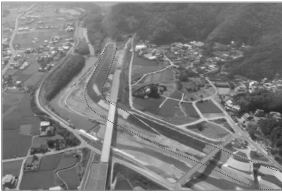
施策1-1 堤防の整備(園瀬川)
