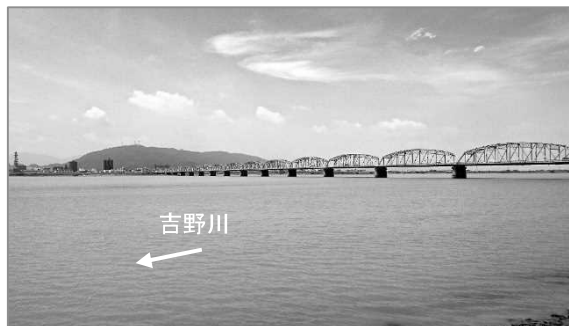
写真2-20 眉山と吉野川橋
