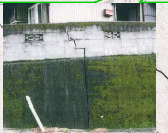
壁面の亀裂
