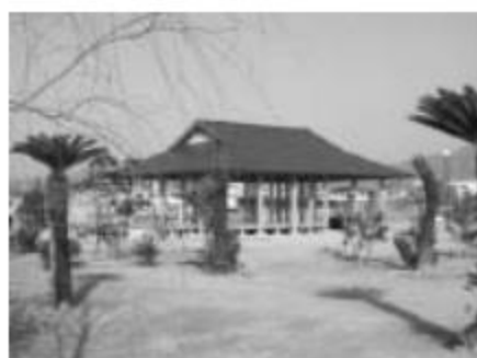
整備された会所建物
