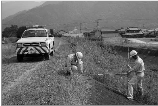
施策4-1 堤防の点検状況
