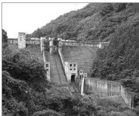
写真2-22 正木ダム(上勝町)
