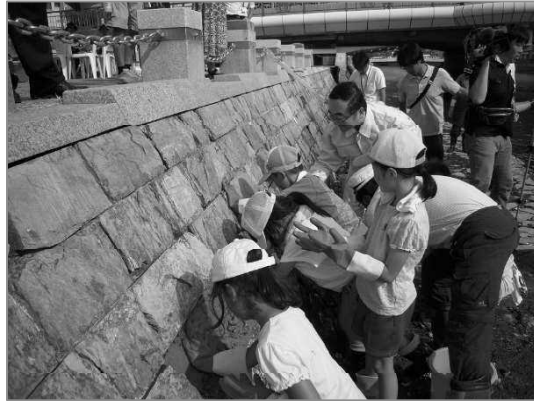
施策4-2 県民と協働による護岸の修理
