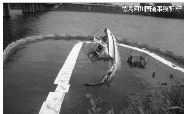
施策 2-4 シルトフェンスによる油等拡散防止
