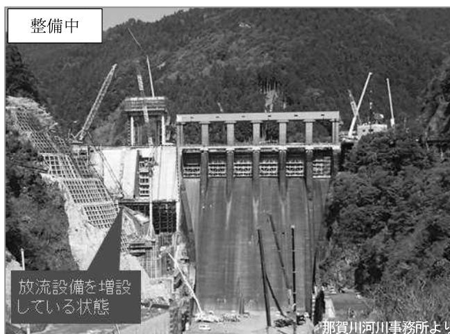
写真2-31 長安ロダムの改造（那賀町）
