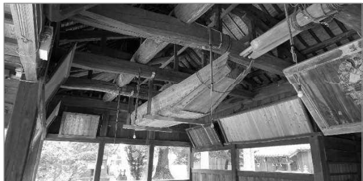
写真2-4 八幡神社拝殿の吊り舟（阿波市市場町）
