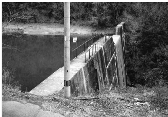
施策2-1 砂防堰堤に貯まった流水
