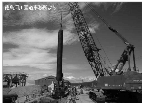
写真 2-34 液状化対策工事
