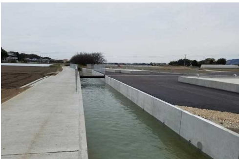
幹線水路（那賀川地区）
