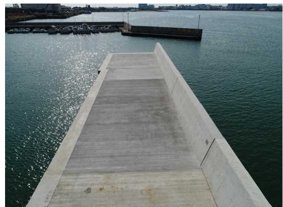
漁港整備（粟津漁港）
