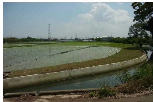
ライニングされた幹線用水路 （麻名用水地区）
