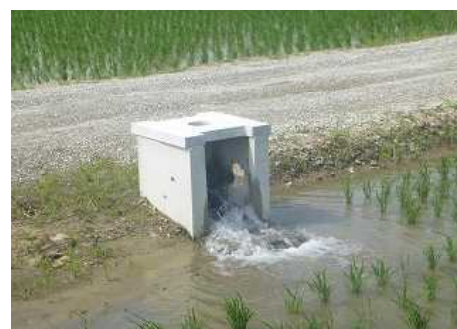
末端給水栓の整備
