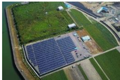
太陽光発電施設
