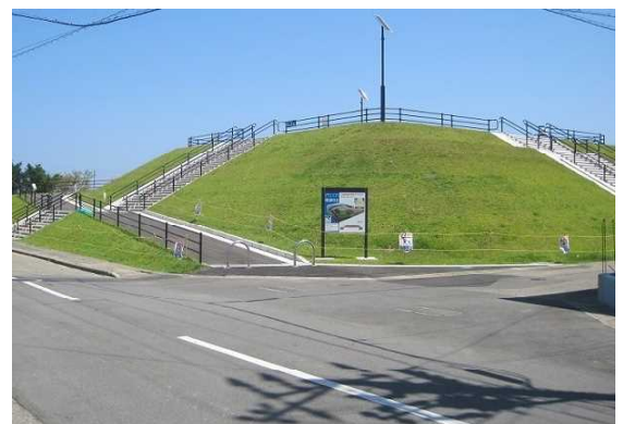
河川の堆積土砂を有効活用した津波避難施設（小松島市）
