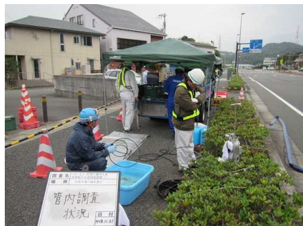
管内カメラによる点検の事例
