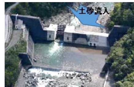
貯砂ダムによる土砂流入の軽減
