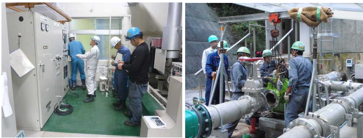
ダム施設の定期点検と維持補修（正木ダム）
