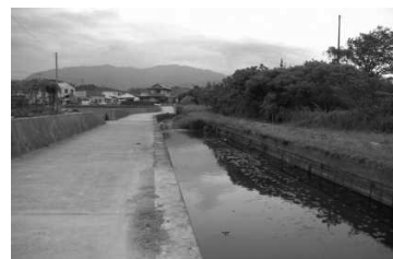
直線化された水路
