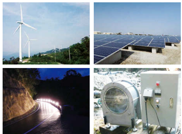
左上：風力発電、右上：太陽光発電 左下：那賀町小水力（街灯）、右下：那賀町小水力（装置）
