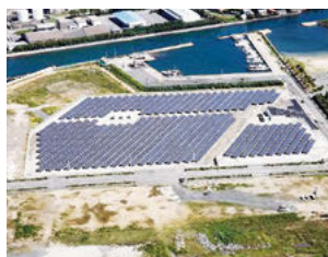
和田島太陽光発電所
