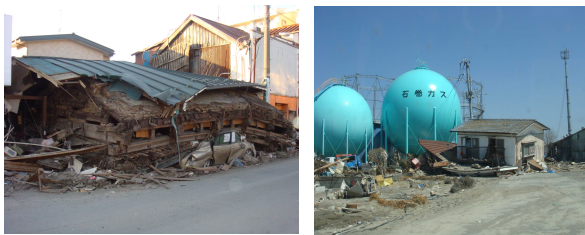
東日本大震災被災状況（宮城県石巻市）
