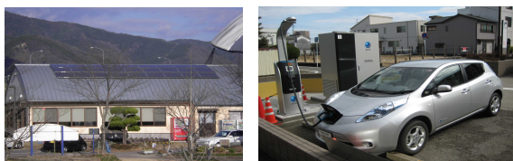
太陽光パネル設置施設 EV用急速充電設備
