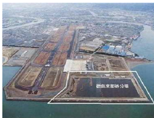
徳島東部処分場（管理型最終処分場）
