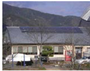
太陽光パネル設置施設
