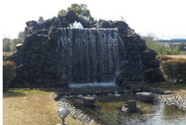
浄化用水ポンプ
