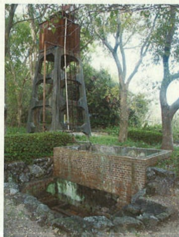
第2 給水施設と引揚者住宅時の給水塔
