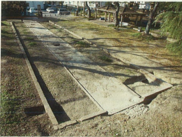
しょうしゃ 廠 舎第5棟跡 建物基礎
