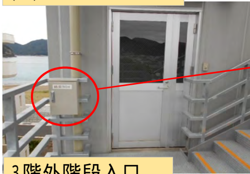
3階外階段入口
