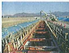
「国営吉野川下流域地区」幹線用水路の施工状況
