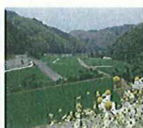
特西部地区のほ場整備
