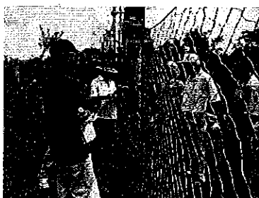
侵入防止柵（ネット柵）
