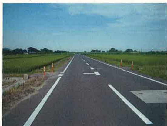
大型機械の進入が可能となった農道整備
