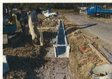
老朽化した水路の更新
