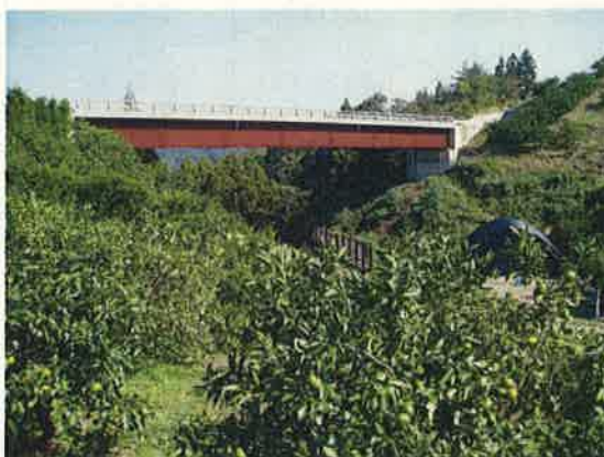
集落間を結ぶ農道橋の整備
