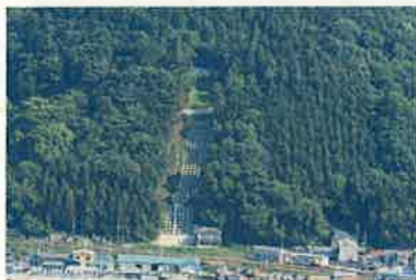
山地災害から 公共施設・人家等を保全
