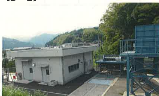
排水機場(阿南市)
