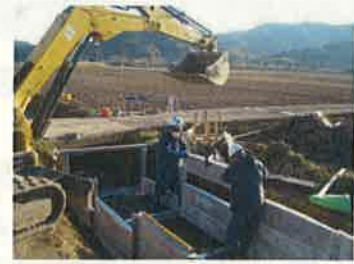
老朽化した水路の更新
