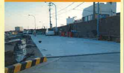
機能保全工事
