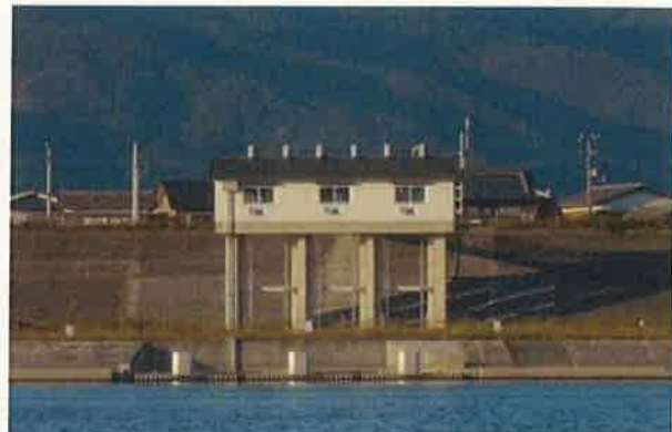
国営総合農地防災事業 取水工
