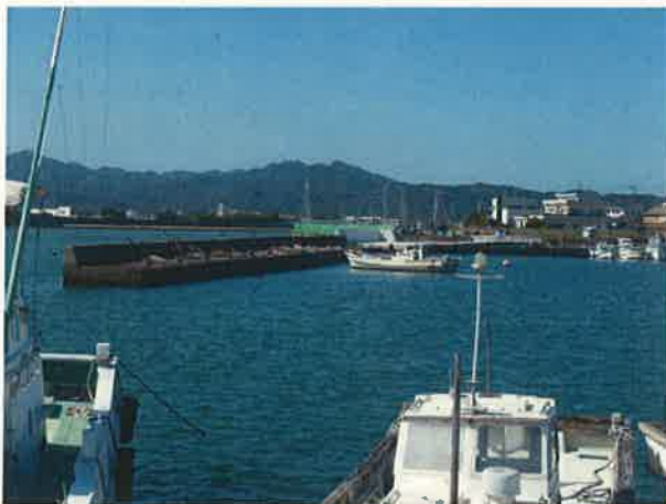
整備中の防波堤改良事業
