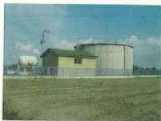
畑地かんがい施設（揚水機場）
