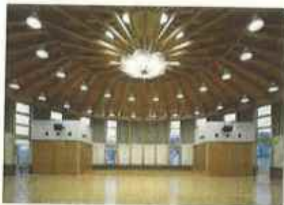
大型木造施設
