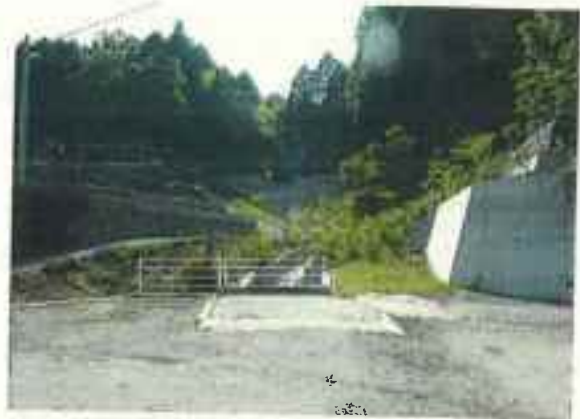
治山ダム（谷止工）
