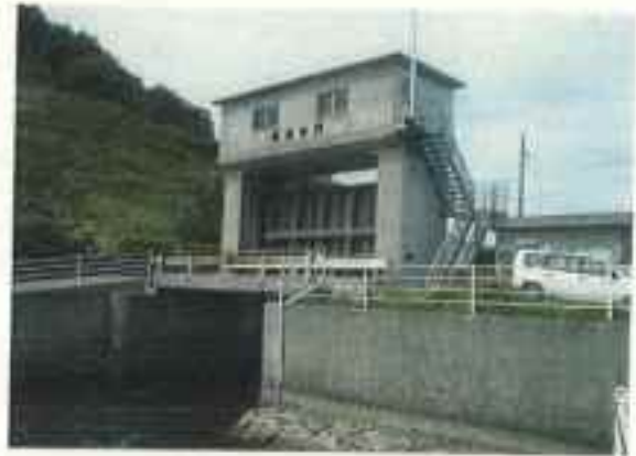
自動化された水門
