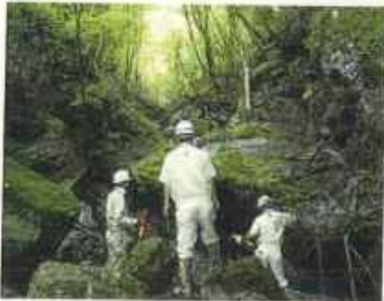
危険地区の点検
