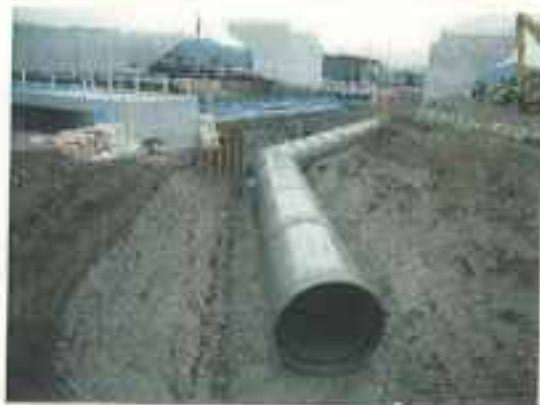
用水路のパイプライン化（国営事業）
