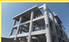
津波避難タワー
