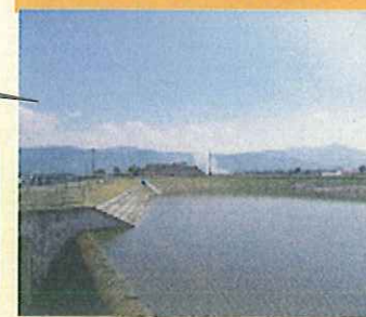
農業用ため池の整備
