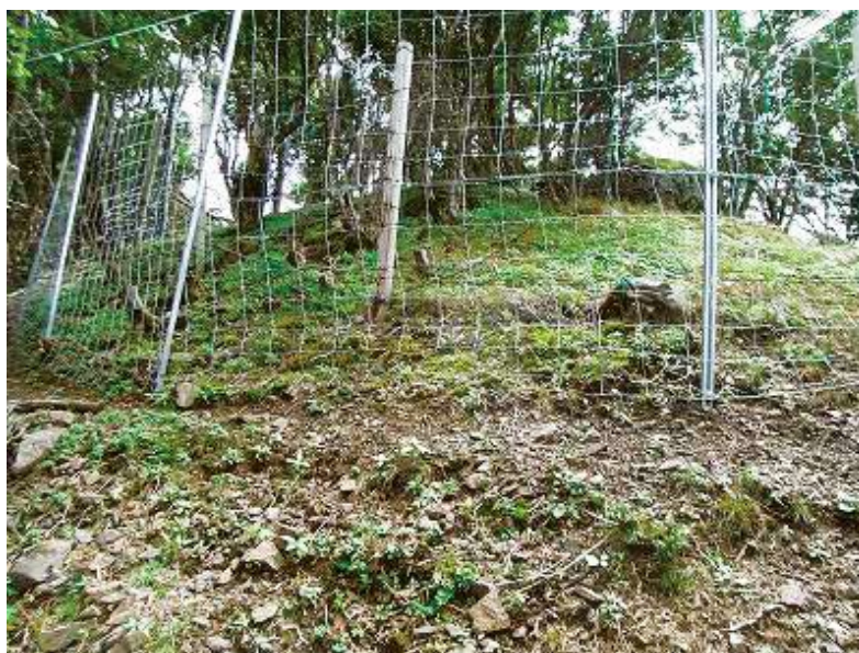
保護ネット設置状況
