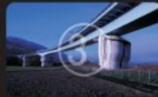
吉野川橋(徳島自動車道)
