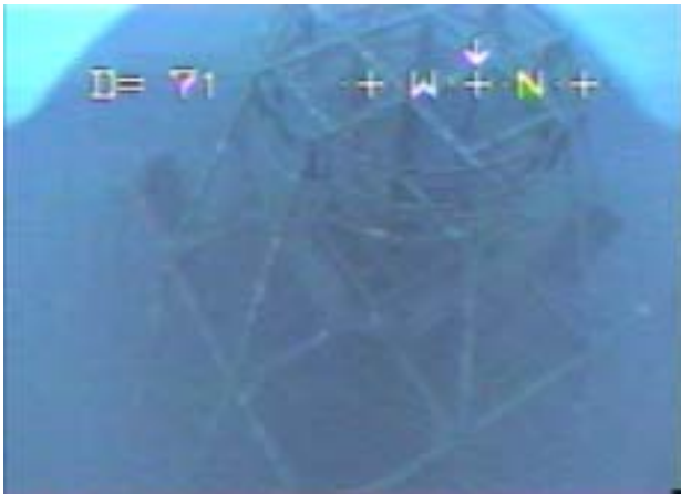
写真1. 鋼製魚礁スターリーフ I-4N型の上から見た外観
